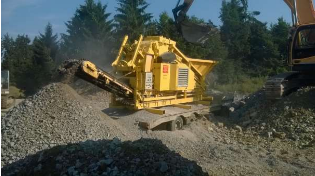
Slika 2. Mobilni uređaj za mehaničku obradu građevnog otpada Rumble Master RM 601AB98 u pogonu
